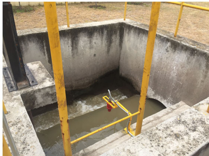
Planta de tratamiento abandonada en San Martín Texmelucan
